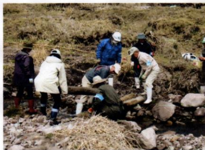
城島川の橋梁架け作業
