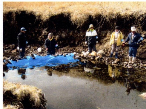
城島川にシートを使って作った堰
