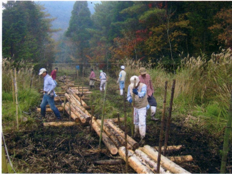
間伐材を使った仮設木道の整備作業
