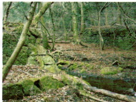
写真3. 橋畔の石積み
