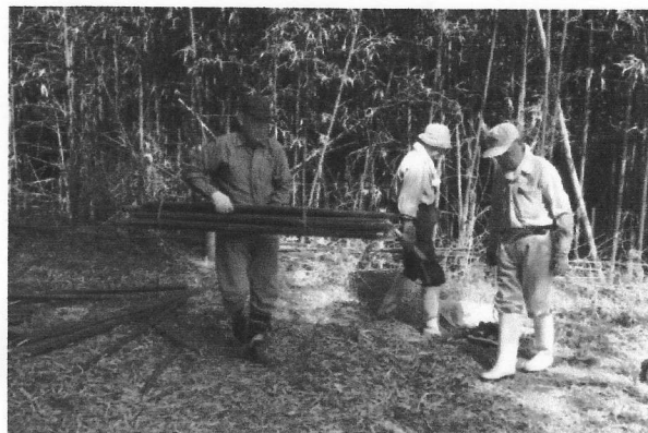
保護柵支柱用タケ切り出し作業
