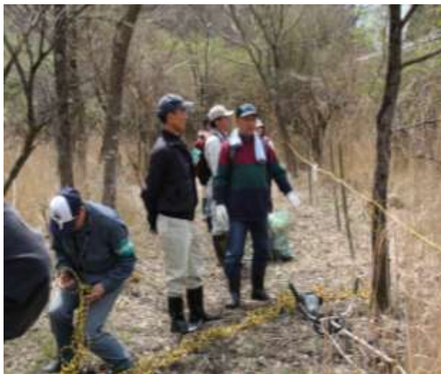
ロープ囲いの作業
